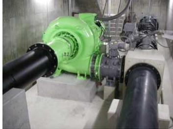
県水道局桜井浄水場小水力発電施設 (197kW)
