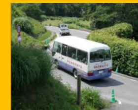
狭隘区間の整備
