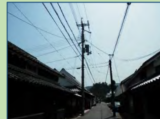
電線類地中化の整備・延伸
