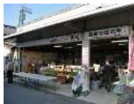
《写真 旧JA倉庫を改修した町家カフェ(左) 旧JA車庫を利用した農産物直売所(右)》
