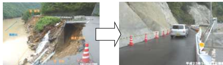
道路の応急復旧 (十津川村桑畑)
