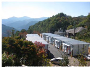
五條市大塔町阪本地区 平成23年10月28日撮影
