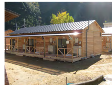
十津川村平谷地区 平成23年11月15日撮影
