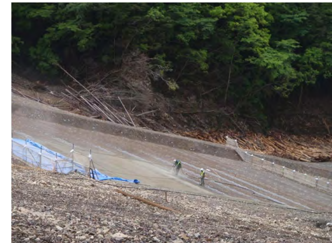
栗平地区の工事状況 (2012年5月25日撮影)
