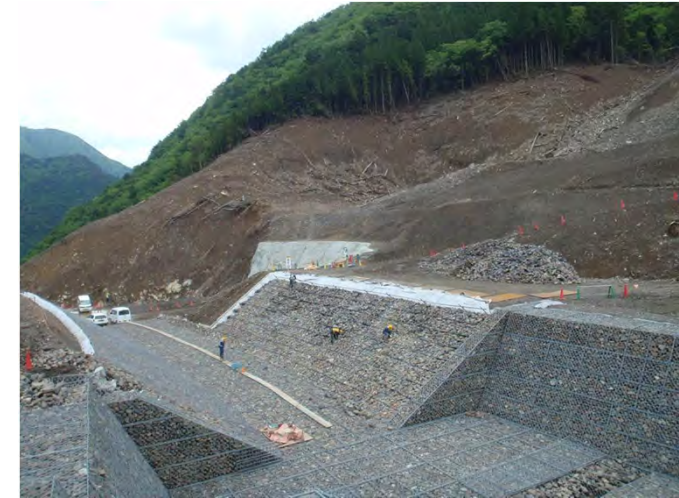
赤谷地区の工事状況 (2012年5月25日撮影)
