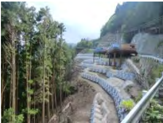
市道敷地外へ作業用盤台設置済み 平成26年5月22日撮影
