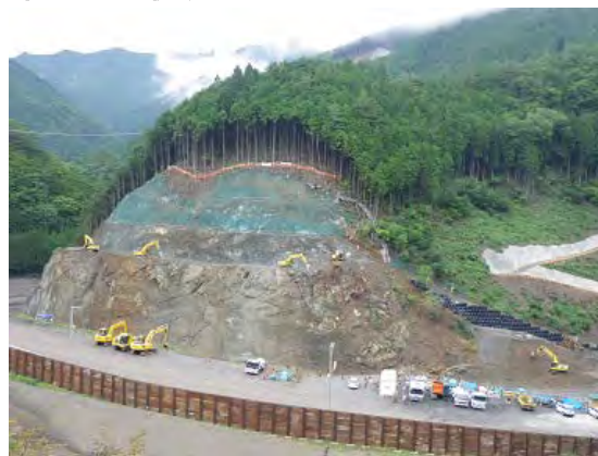
平成26年8月29日撮影 (河道拡幅状況)
