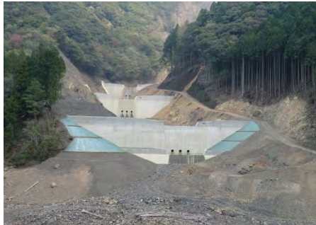
1号谷止工(手前)完成 平成26年4月17日現在
