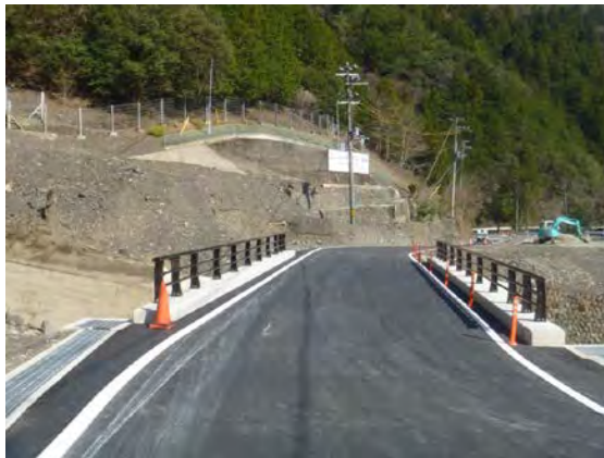
国道168号 十津川村長殿(完成供用済) 平成26年3月28日撮影
