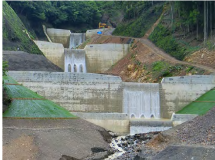
4号谷止工(最奥)施工中 平成26年8月8日現在
