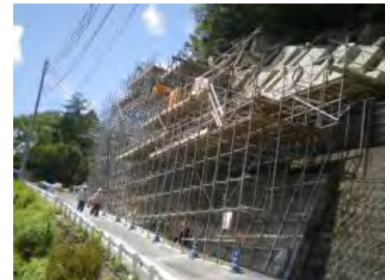
市道災害復旧工事(アンカーボーリング施工中) 平成26年8月20日撮影
