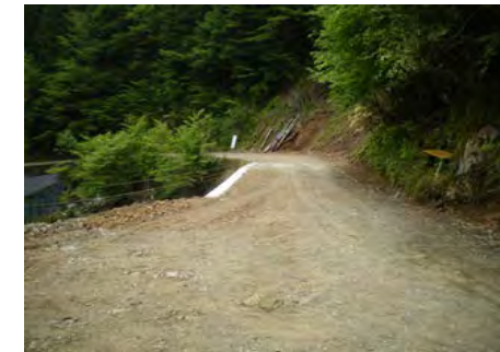
林道コノ谷線5号(完成) 平成26年7月24日撮影
