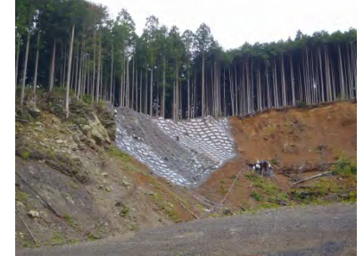
平成26年8月6日撮影 法枠工(施工中)
