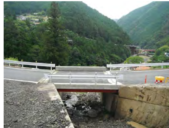
国道168号 五條市大塔町辻堂 平成26年8月29日撮影
