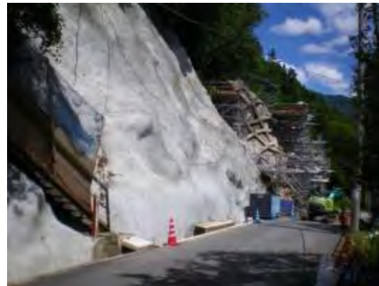
市道災害復旧工事(モルタル吹付工完了) 平成26年8月20日撮影
