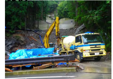
平成26年8月4日撮影 2号3号谷止工完成、1号谷止工(施工中)
