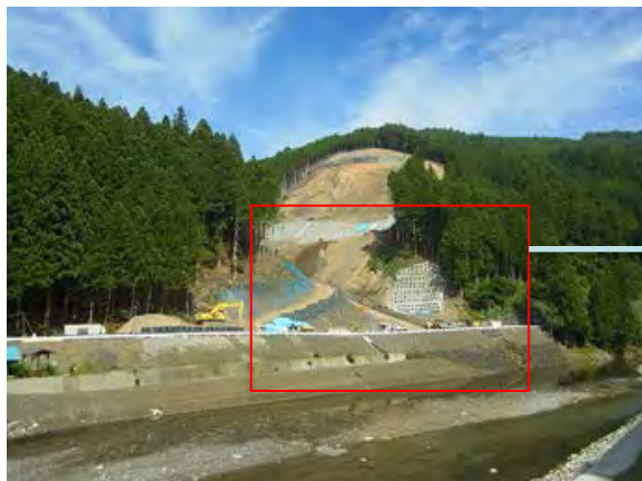
高野天川線 天川村南日裏 平成26年8月1日撮影
