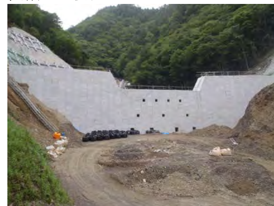
平成26年8月22日撮影 (堰堤設置状況)
