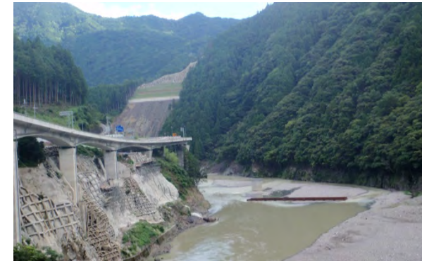
十津川道路(平成26年8月5日撮影)
