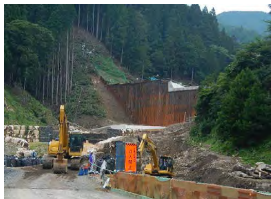
平成26年8月12日撮影 (溪流保全工掘削状況)
