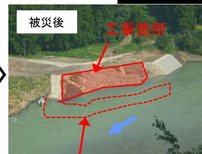
工事用道路流失
