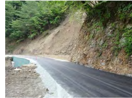
林道奥千丈線2号(完成) 平成26年7月25日撮影
