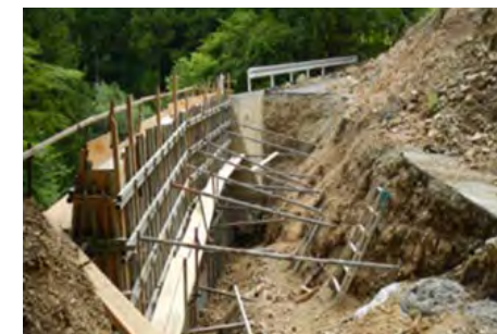
林道殿野坪内線6号(擁壁工施工中) 平成26年7月24日撮影
