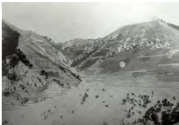
明治・大正時代施工の山腹工事
