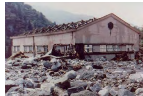
土砂に埋まった称名川発電所
