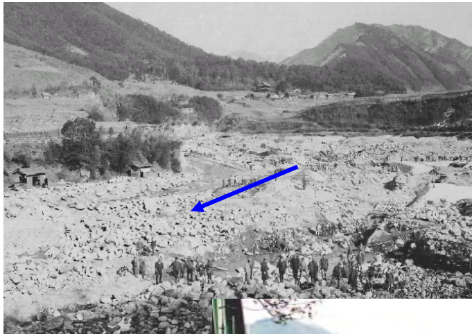
施工当時の状況
