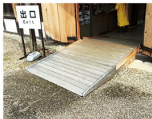
↑施設出入口スロープ
