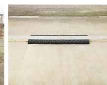
↑門(敷居)の段差解消スロープ
