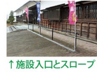
↑施設入口とスロープ
