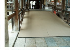
↑本堂入口のスロープ
