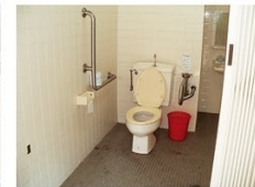
↑駐車場近くのトイレ
