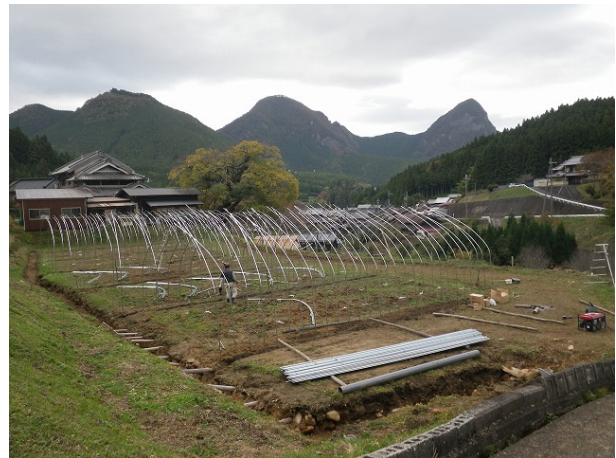
新規就農者の建設中パイプハウス(H26)
