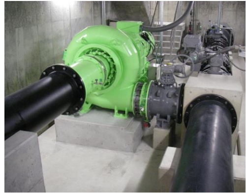
☐小水力発電システム(桜井浄水場)
