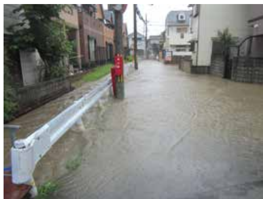
平成25年6月 低気圧により浸水(大和高田市田井新町地内)
