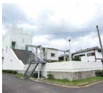
久度雨水ポンプ場
