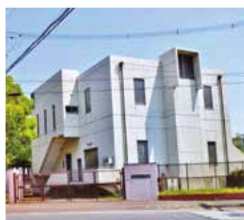
本町総合ポンプ場
