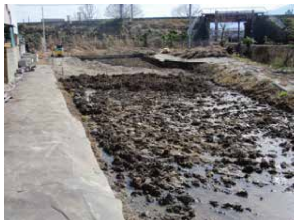
遊休農地を活用した貯留施設（現在工事中）
