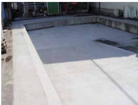
空地を活用した貯留施設
