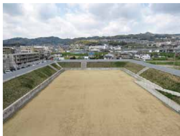
久度第2雨水貯留池（貯留量30,000㎡）
