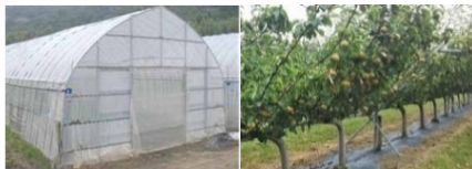
ハウス・樹園地の再整備・改修
