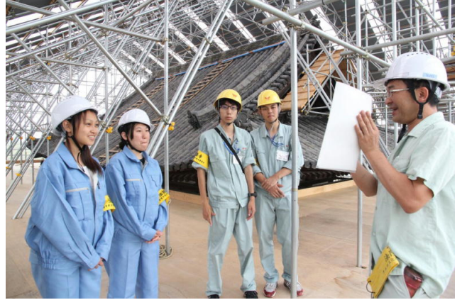
修復現場(中門)
