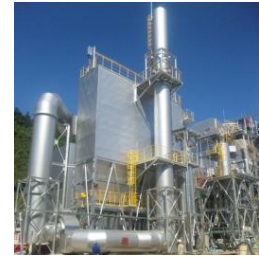
木質バイオマス発電所(大淀町)
