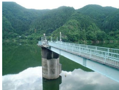
室生ダム取水塔
