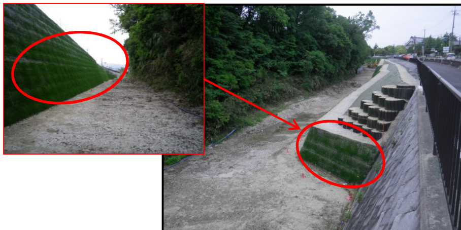
緑化を行った補強土壁 平成28年4月25日 撮影
