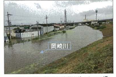
安堵町(岡崎川・大和川合流樋門付近) 8/9 14:40頃
