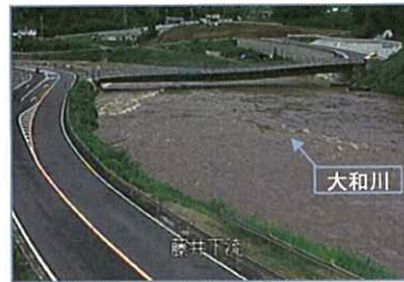
大和川(亀の瀬橋付近) 8/9 14:40頃
