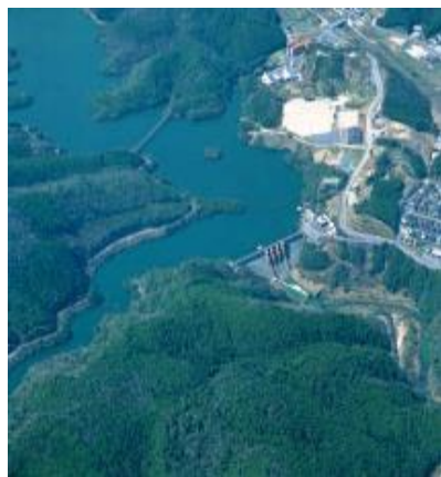
室生ダム(S49竣工) 水源能力:約138千 m^3 /日
