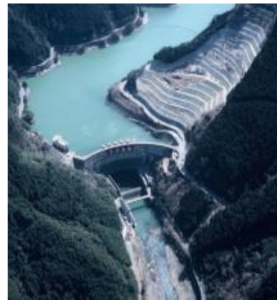
大迫ダム(S48竣工)
