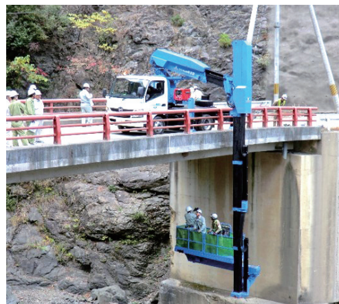
橋りょうの点検(野迫川村)
