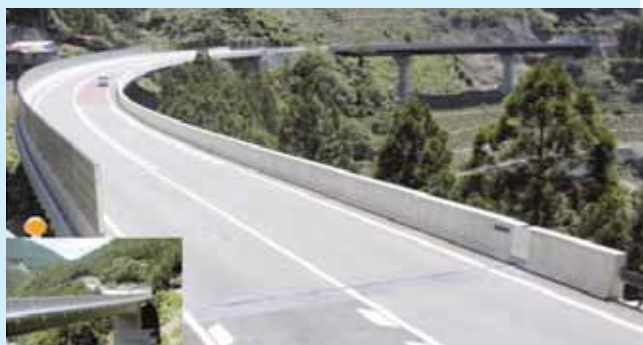
地域連携推進事業（国道改築） （五條市大塔町国道168号新閉君橋）
