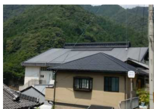
太陽光パネル (体育文化センター)
