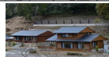
<十津川村復興住宅>
