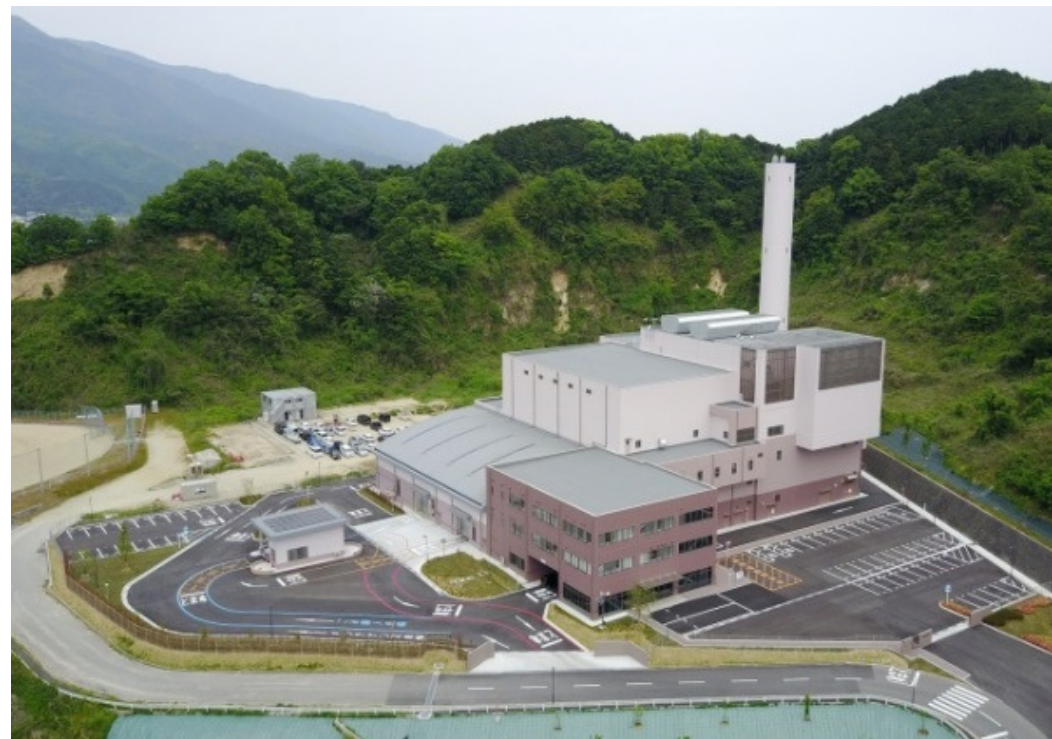
やまとクリーンパーク (やまと広域環境衛生組合) (平成29年6月完成)
