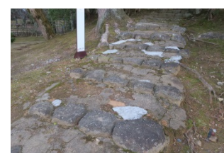
写真: 痛んだ踏面
