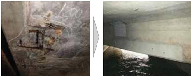
▲橋梁における部材の劣化状況例
