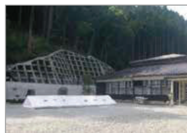
▲避難所を保全する急傾斜施設 (御杖村桃俣)
