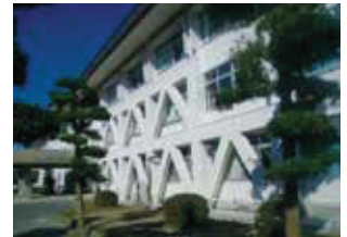
▲県立高校の耐震補強例
