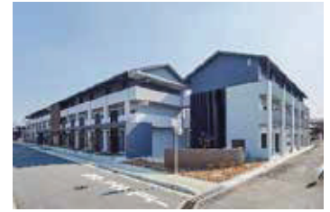
▲桜井県営住宅 第1期建築工事 完成写真
