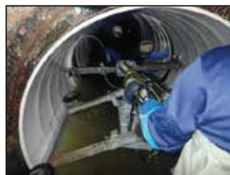
▲老朽化した汚水管の長寿命化
