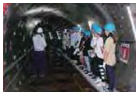
▲一日インターンの様子(流域下水道佐保川幹線工事現場)
