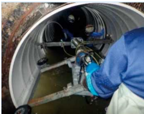
管渠の長寿命化工事 (更正工法による改築)
