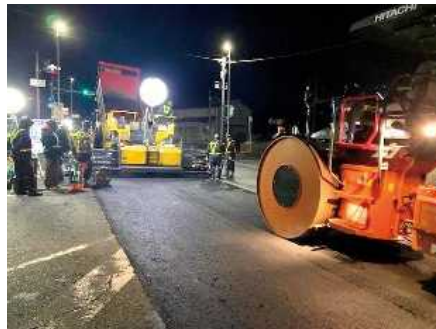
舗装補修工事
