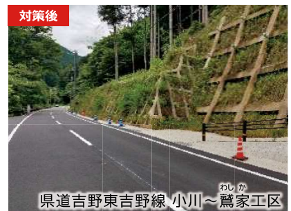
現道拡幅による法面対策
