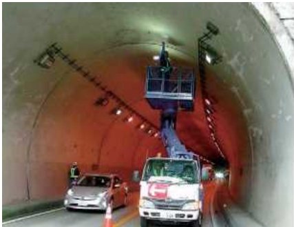
トンネル定期点検
