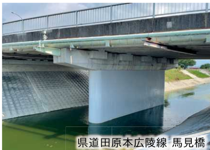
巻き立て工による橋脚の耐震補強工事
