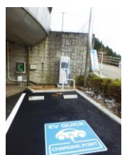
急速充電器の設置(道の駅大塔)
