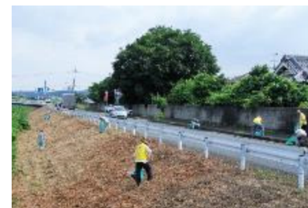
堤防の草刈り (H29.7)
