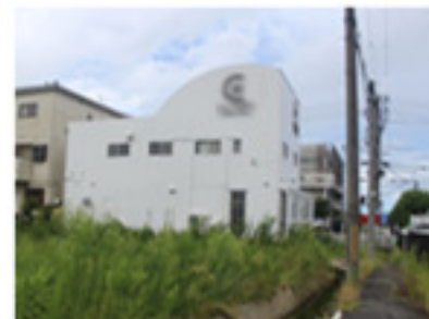
撤去後(H30.8撮影)
