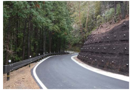
③ (主)高野天川線 上工区 (11工区) 【令和2年3月全線開通】
