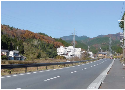
① (一)今木出口線馬佐～新野工区 【令和元年11月一部開通】
