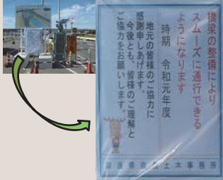
▲県道枚方大和郡山線 中町工区の周知看板
