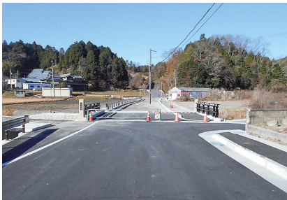
④ (一)助命下萩線 伏拝工区 【令和2年3月全線開通】
