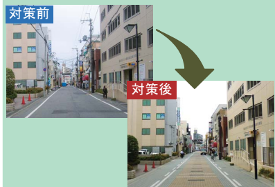
▲無電柱化（県道大和八木停車場線）
