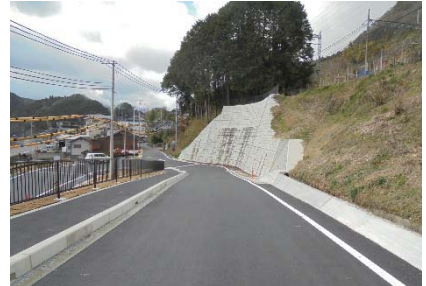
⑥ (一)上笠間三本松停車場線 三本松工区 【令和2年3月全線開通】
