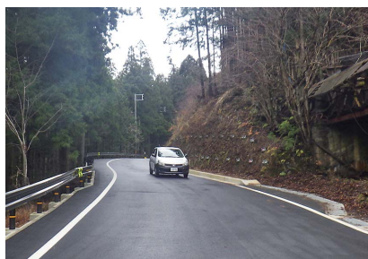
⑧ (主)大峯山公園線 洞川工区 【令和元年8月全線開通】
