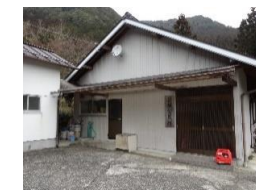
LPガス発電機の設置(十津川村谷瀬)
