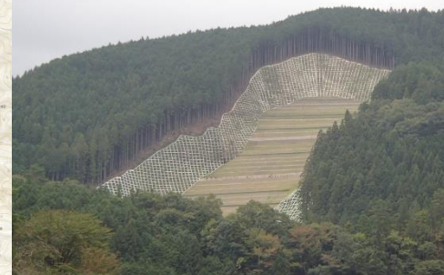
平成24年度より事業 開始、令和3年度完了 見込み
