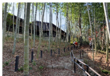
工事中の庭園と宿泊施設
