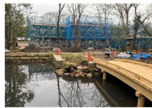
工事中の庭園と飲食施設
