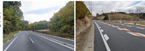
一般国道25号(福住工区) 天理市道上入田都祁線
