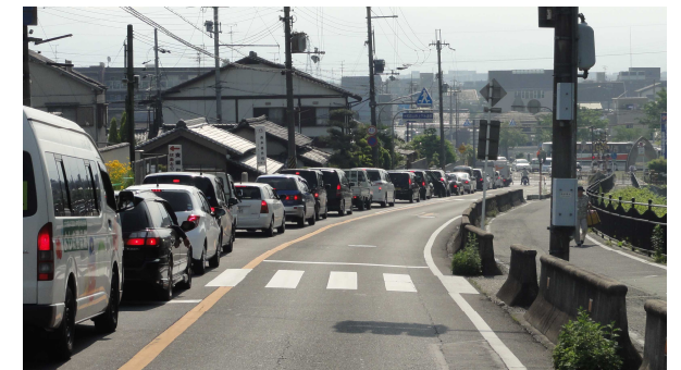
踏切道改良前の混雑状況(踏切西側)
