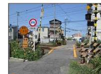
B 南大安寺踏切道 （市道南部第51号線）
