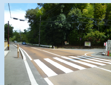
痛んだ舗装の補修
