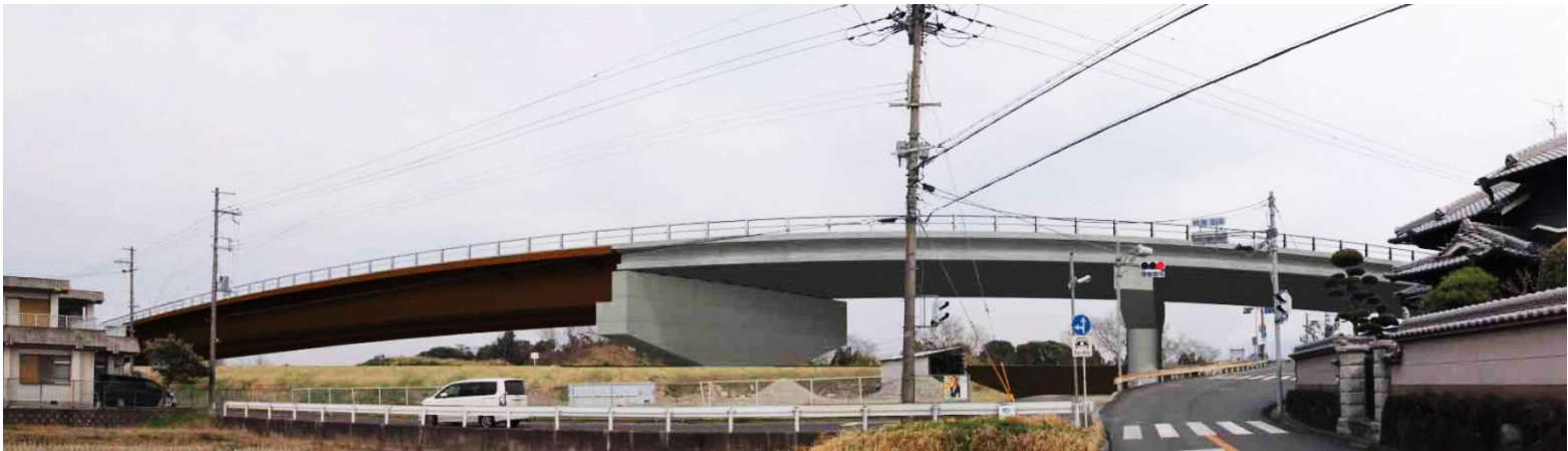
(仮称)新宮前橋
