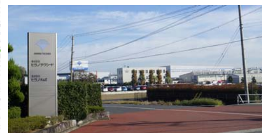
写真3 大型機械製造工場
