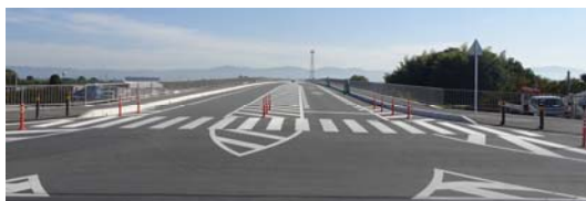
写真2 終点側(河合町市場)
