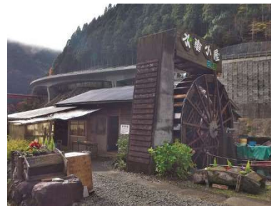
水車と小水力発電設備 （五條市大塔町辻堂）
