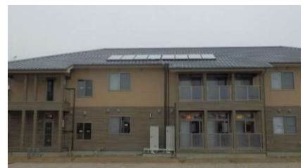
福祉施設への太陽熱利用システムの導入 (2016年度導入事例)
