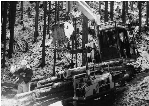
図8 スイングヤーダでの積み込み作業
