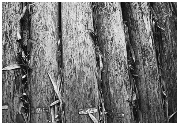
図8 隣接する丸太の隙間に堆積した落葉
