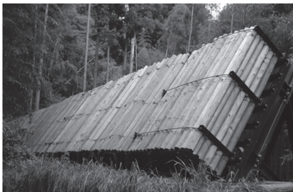
図1 調査対象とした落石防止壁
