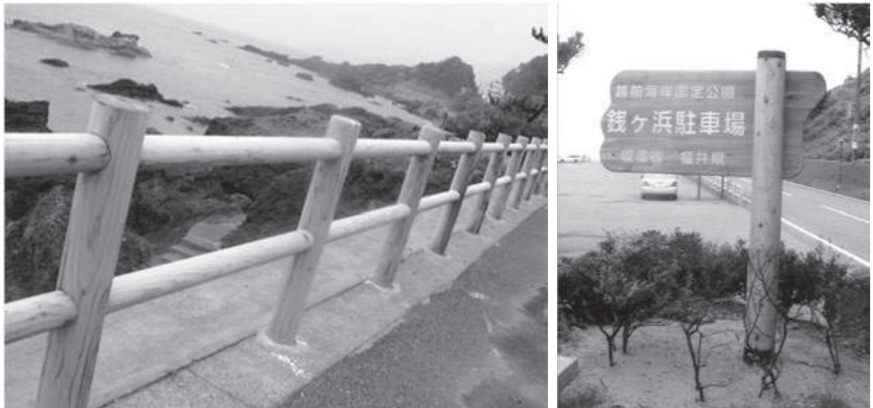
図2 グリオキザール樹脂処理スギ材を用いた越前海岸の木柵と案内板
