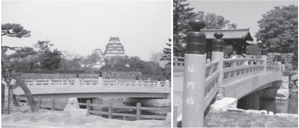
図1 グリオキザール樹脂処理ヒノキ材を用いた姫路城桜門橋の欄干
