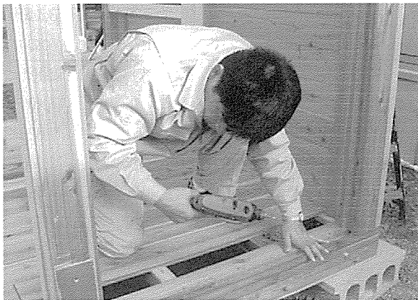
図9 床板の取り付け
