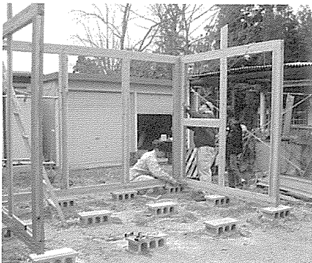
図4 接合金具でフレームどうしを結合
