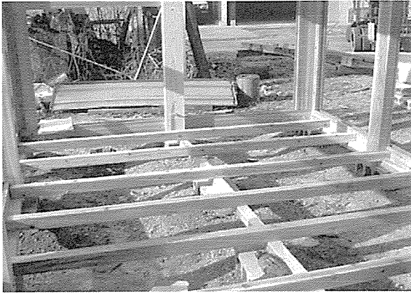
図8 大引きと根太の取り付け
