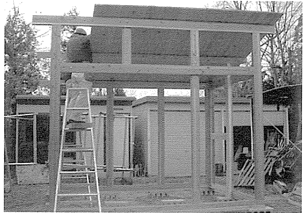
図6 サネ加工した下地をビスでとめる
