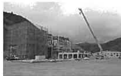
木質バイオマス発電所(建設中)
