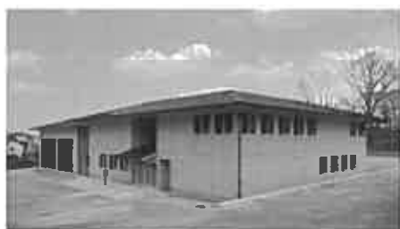
奈良公園事務所(内外装木質化)
