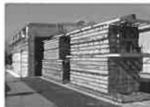
木材乾燥設備
