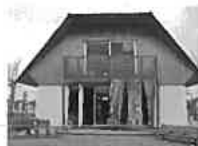
十津川産材を使用したモデル住宅
