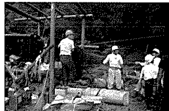
集材用架線の設置状況
