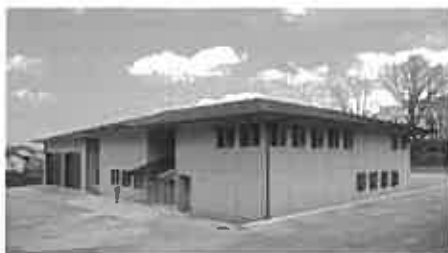
奈良公園事務所(内外装木質化)
