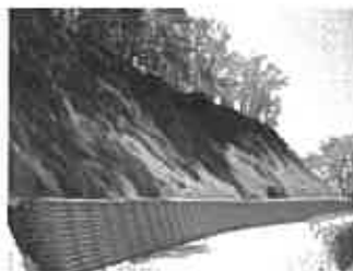
木製校舎擁壁の施工例
