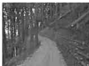
作業道整備完了
