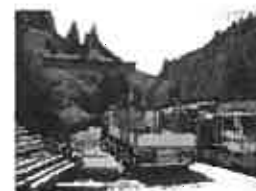
中間土場からの搬出状況
