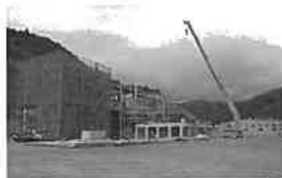
木質バイオマス発電所(建設中)
