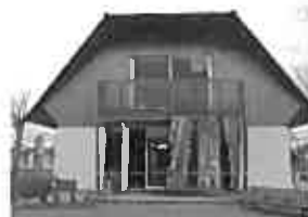
十津川産材を使用したモデル住宅
